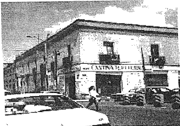
fig. 19 Cantina ubicada en Dos de Abril y Pensador Mexicano
