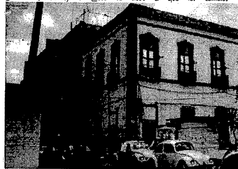
Figura 21 Esquina santa Veracruz y Dos de Abril, deterioro físico de la zona.
