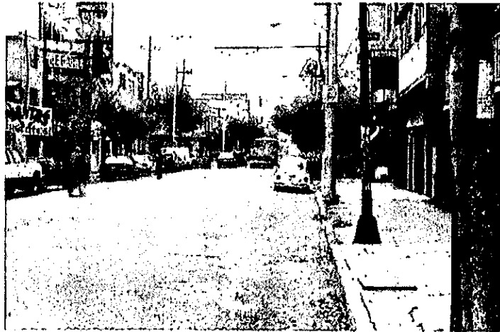
En esta fotografía puede apreciarse el deterioro y abandono de la zona.
