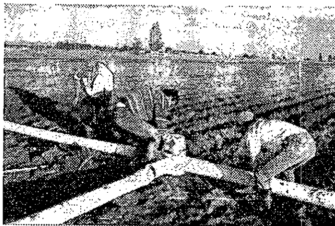
Fotografía 4-1 Instalación de la válvula.
