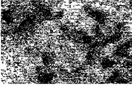
Las áreas oscuras que producen un efecto moteado corresponden a los agregados que se encuentran cerca de la superficie. Esto ocurre cuando el concreto no es bien vibrado o la pasta endurece muy rápido
