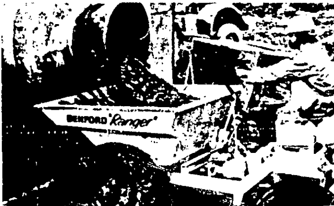
Fig. 12 Buggie capacidad de 0.5 \text{ m}^3 recibiendo concreto de una mezcladora de tambor reversible
