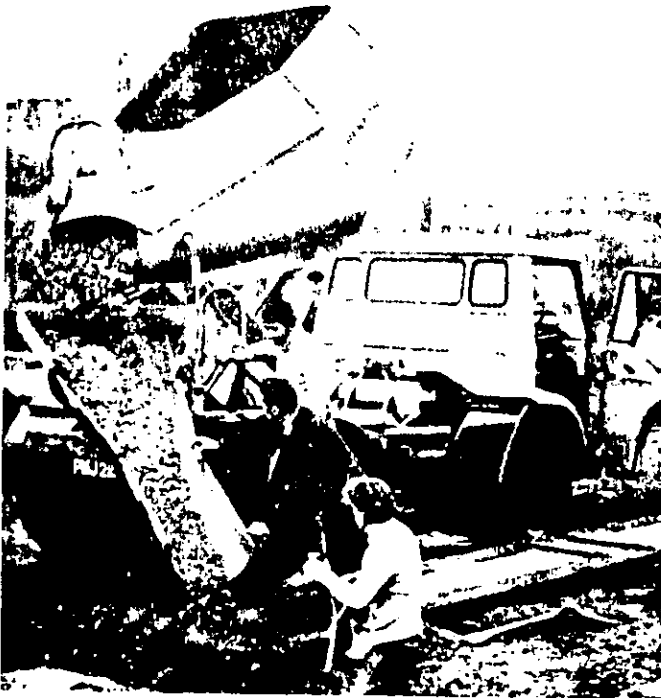
Fig. 13 Transportador montado en un camión capacidad 2-3m 3 descargando en una fosa para cimentación
