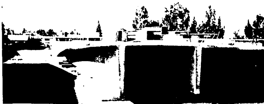
Fig. 17 Trabes TT son elementos estructurales de concreto pretensado prefabricado.
