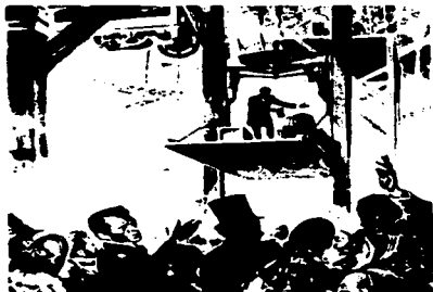
fig. 4.2 Demostración del primer ascensor con freno de emergencia diseñado por Otis.
