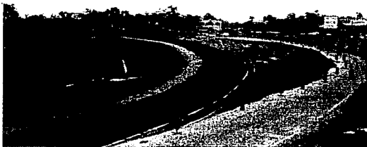
FOTOGRAFIA IV.1 Obras en el interior del Complejo Militar, reposición de camino interior.
