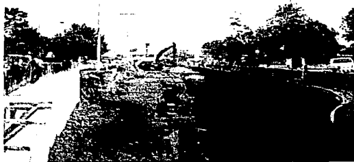
FOTOGRAFIA IV.9. Excavación sobre el anterior camellón sobre la avenida Paseo de la Reforma.
