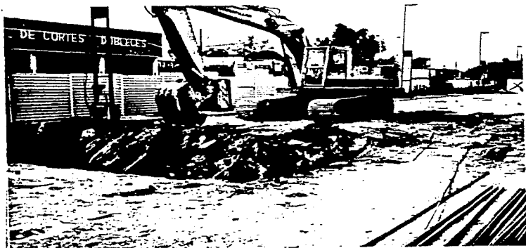
EXCAVACION PARA CAJON DE CIMENTACION
