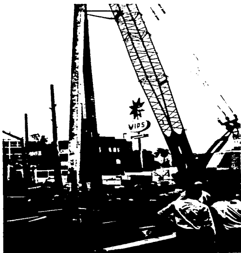
HINCADO DE PILOTES
