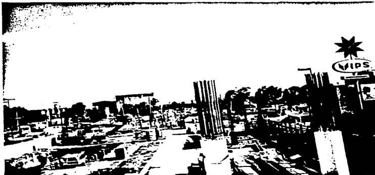
VISTA DE LA CONSTRUCCION DESDE LA ZAPATA No. 7
