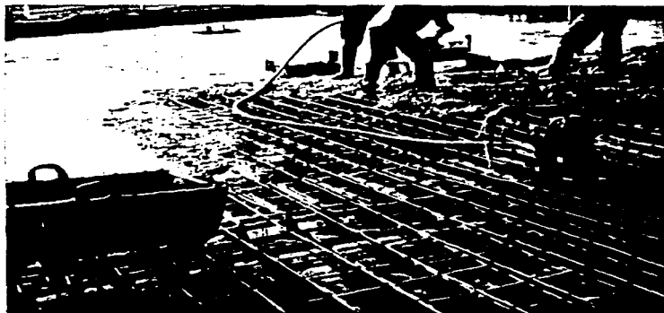
COLADO LOSA TAPA
