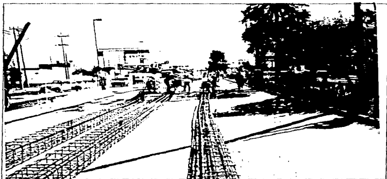
ACABADO DE PILOTES
