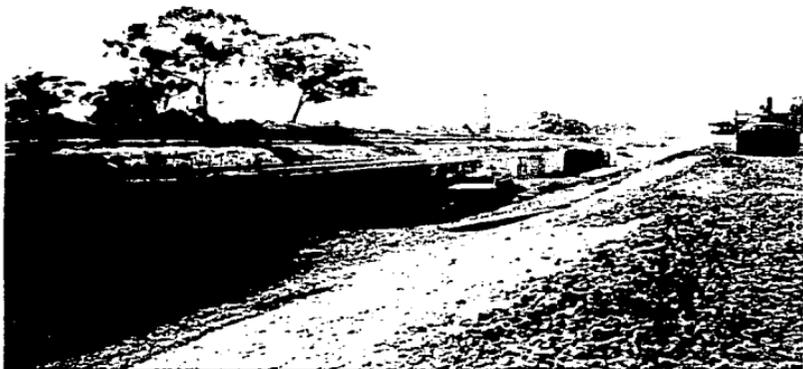
EXTENDIDO DEL TEZONTLE PARA EL ACOSTILLAMIENTO DEL CAJON
