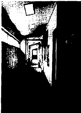
Corredor del 2° piso del edificio "B"
