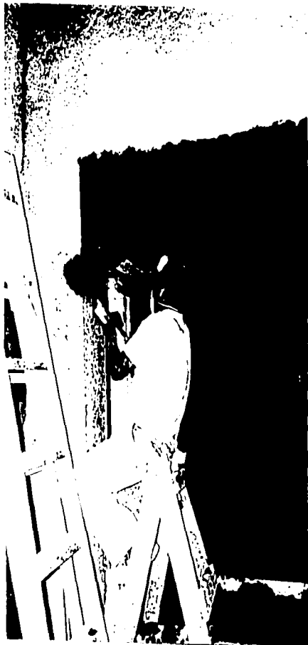
Fotos 40 y 41 : Detalles del arco. En la gráfica de la izquierda se nota el metal desplegado con el que se le dió forma al arco. En la imagen de la derecha, un trabajador efectúa los detalles.
