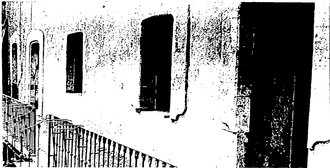
Foto 61 . Vista parcial de la fachada interior en Planta Alta. La cantera está ya terminada. Incluso la instalación eléctrica está concluida. Los muros están listos para recibir la pintura. En primer plano a la izquierda nuevamente tenemos el barandal, reintegrado totalmente.
