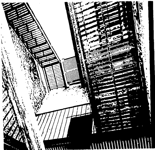
Fotos 122 y 123. Estas dos gráficas nos muestran el nuevo cubo de escalera y servicio. Se eligió una escalera metálica exenta de los muros en sus laterales. En la imagen de la izquierda se nota con claridad el procedimiento constructivo de los muros.
