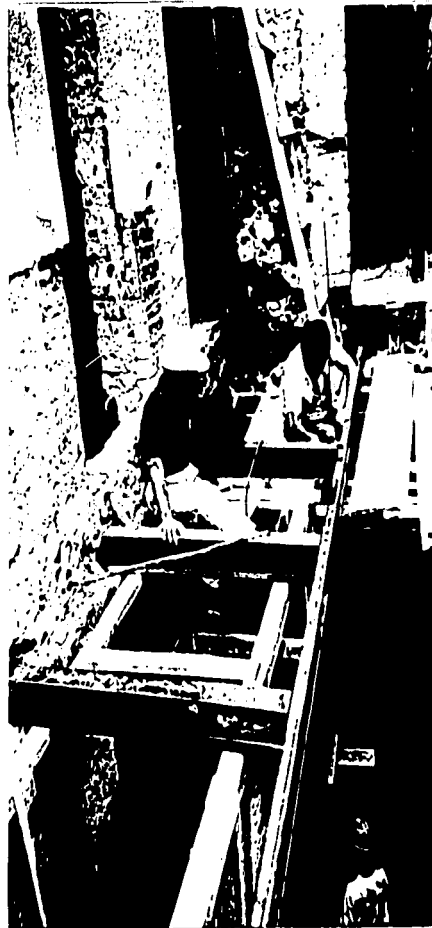
Foto 102: A las viguetas se les soldó un montón de 6" para unir las puntas >
