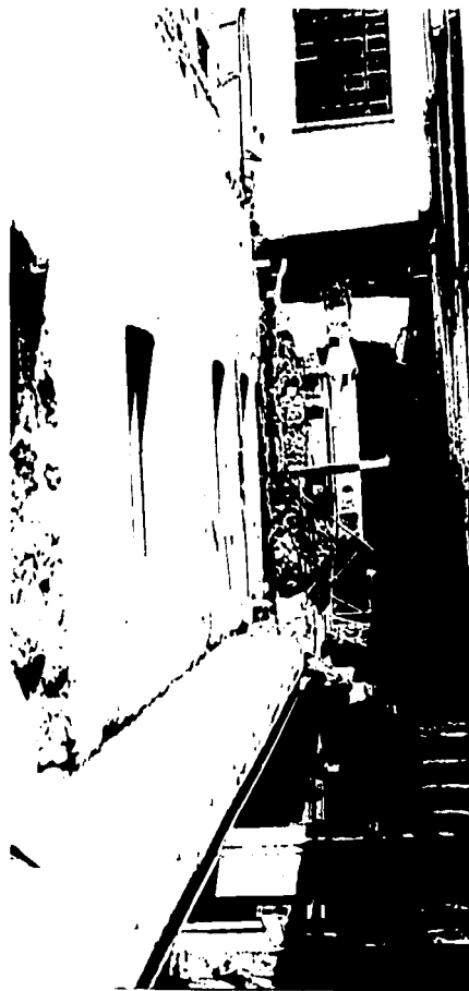
Foto 108: La misma vista ya con el andador colado. Todavía no se intervenía la fachada del fondo.
