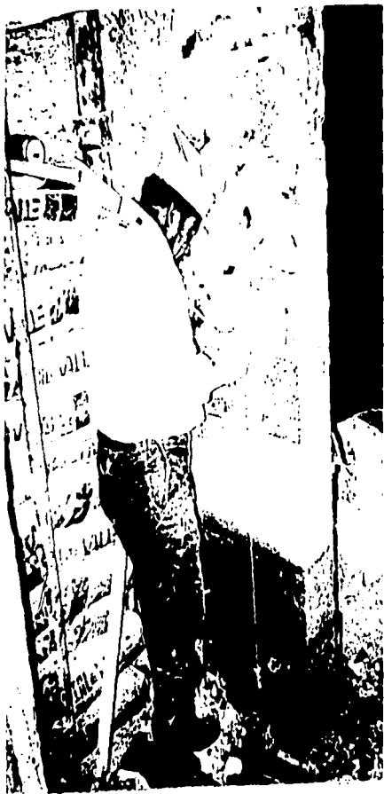
Foto 75 : El cantero inicia de abajo hacia arriba cuidando "el plomo" en la colocación.
