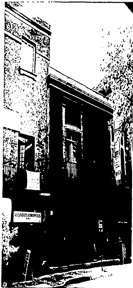
Foto 4. Vista de la fachada de la casa. Debido al procedimiento de colocación de los sillarejos de tezonilla tanto en el primer cuerpo de la fachada como en el segundo, suponemos que no son originales.
