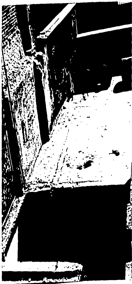
Foto 27: Losa de azotea del Salón Principal libre de una construcción bodega que se encontraba sobre ésta. Se alcanzan a percibir las "huellas" que dejaron los muros
