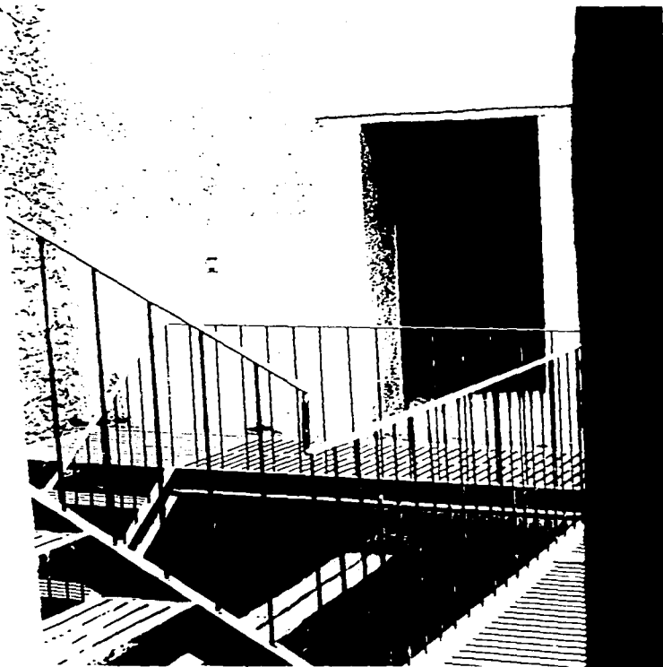
Foto 124: Detalle de la herrería del barandal de la escalera de servicio. Se eligió el mismo criterio del barandal del andador principal en Planta Alta, pero sin "plomos".
