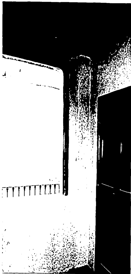
Fotos 66 y 67: Detalles de la carpintería mostrando el "enpapelado" para proteger los aplanados del barniz -izquierda-. Todas las puertas estaban cubiertas con esmalte, mismo que se retiró. Obsérvese cómo la puerta presenta la chapa original -derecha-.
