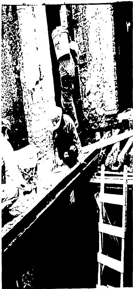
Foto 97. Trabajadores retirando la losa de zinc que sustentaba el antiguo andador.
