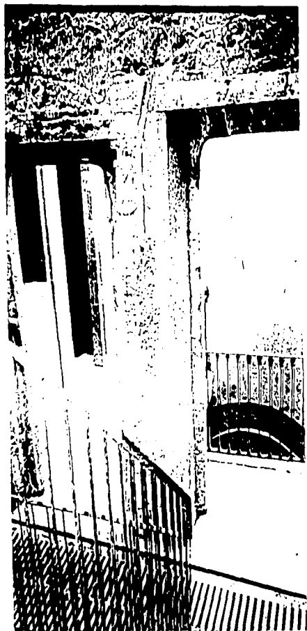
Fotos 122 y 123. Estas dos gráficas nos muestran el nuevo cubo de escalera y servicio. Se eligió una escalera metálica exenta de los muros en sus laterales. En la imagen de la izquierda se nota con claridad el procedimiento constructivo de los muros.
