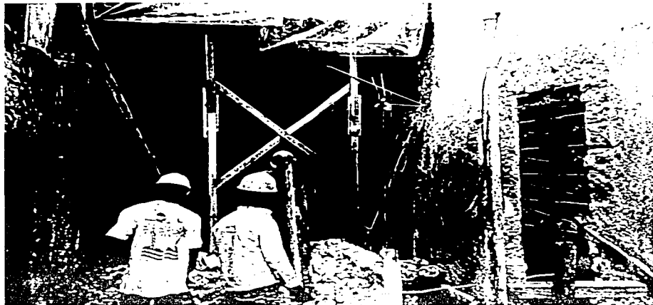
Foto 94. Los trabajadores de la obra se ocupan de la colocación de los muros de los mesones, para dar lugar a la colocación de los arcos de los arcos de los mesones.
