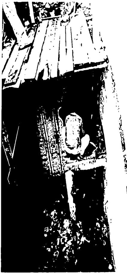
Fotos 31 y 31B : Estas dos gráficas nos muestran los trabajos de liberación de una construcción no original. En este caso se trata de un baño en Planta Baja. Uno de los trabajadores -el de gorra- está parado sobre unos lavaderos que también eran agregados. Posteriormente, también se retiraron.
