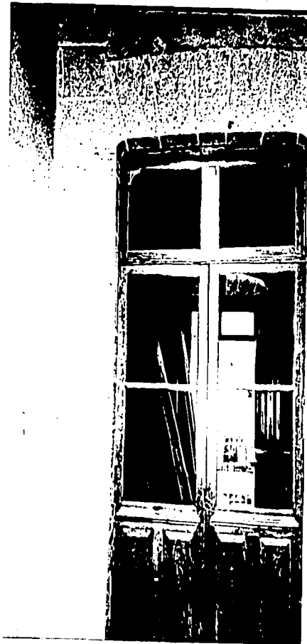
Foto 65 : Puerta del Salón Principal que comunica a la terraza sur. Al igual que en la imagen anterior la madera está lista, aunque todavía no tiene la vidriería colocada. Nótese como también la cantería está concluida.
