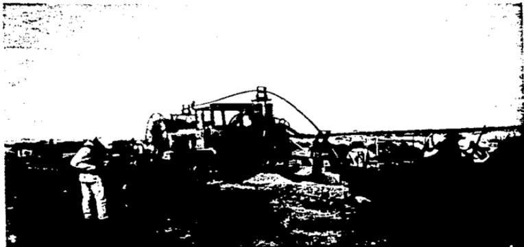
Instalación de flexoducto 2" (5.08 cm.) de diámetro, en el derecho de vía de la autopista de cuota Nuevo Laredo - Monterrey; est. 132 + 300.
