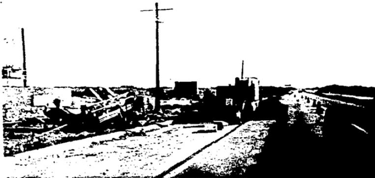
El equipo de perforación mostrado en la figura, es un equipo DITCH WITCH DD-25, tanto para perforación horizontal como direccional; tiene una presión de penetración/jalado de tubo de 25000 PSI (1757 kg/cm<sup>2</sup>), una presión de rotación de la broca perforadora de 6000 PSI (422 kg/cm<sup>2</sup>); la longitud de los tubos de acero para perforación es de 4.00 m. con preparación de rosca en los extremos.
