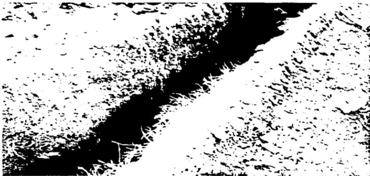
En la ilustración se aprecia el estrato arcilloso superior, la profundidad es de 0.90 m. Localidad, Nuevo Laredo, Tamaulipas. Notese que el ducto ha sido instalado.
