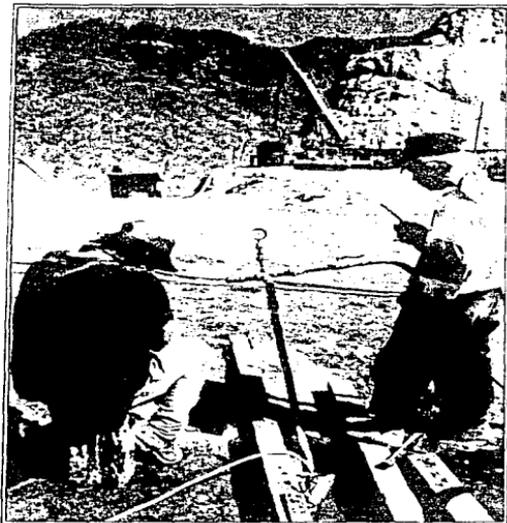
b) En la foto se observa al personal de inyección, encargado de llevar el control de la inyección y para ello se auxiliaban de un radio para comunicarse con la planta, para disminuir o aumentar la presión de inyección.
