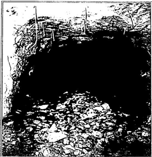
Figura 2.27 En la gráfica se observa como penden del techo la manguera testigo y la manguera de inyección
