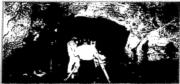
Figura 2.18 Trazo topográfico en el interior de las galerías para cuidar el alineamiento, la dirección y poder calcular el volumen de esa voladura, así como llevar un buen control de avance de obra.
