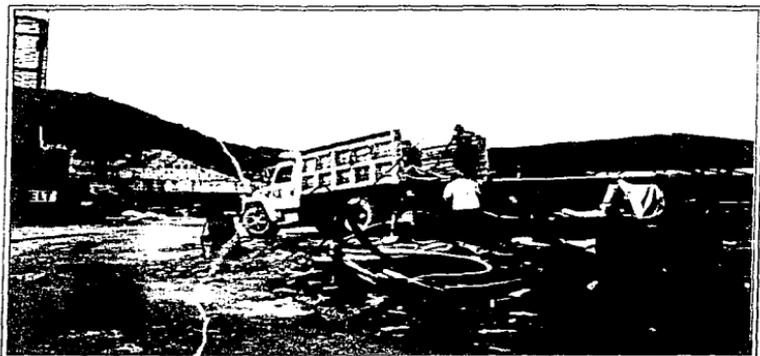
Figura 2.42. Suministro de la mezcla seca a la aliva lanzadora para su colocación en el interior de la galería.
