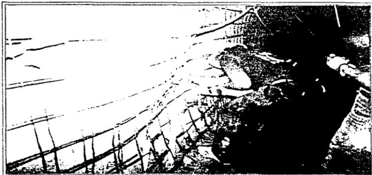
Figura 2.44 Colocación de malla doble para simplificar el proceso constructivo y así lograr un avance mayor
