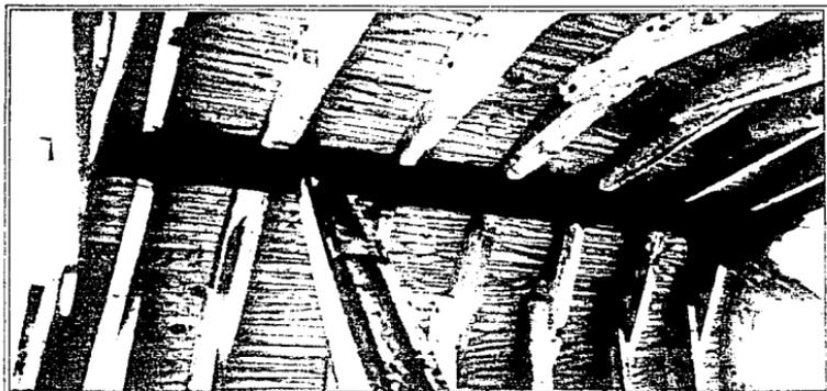
Figura 2.38 Cimbra autosoportable diseñada especialmente para revestimiento en muros y bóveda
