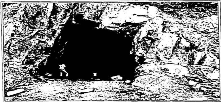
Figura 2.48 Aspecto general del tapón de concreto para continuar la colocación del enrocamiento en la cortina.
