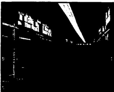
**FIGURA 5.- Iluminación fluorescente semidirecto provee una iluminancia vertical en cajas en un almacén.**
