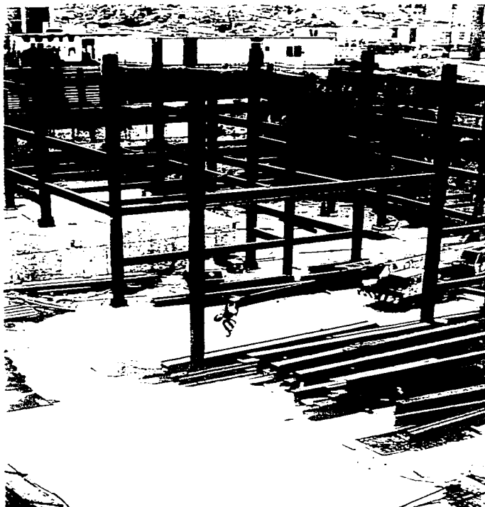
CONSTRUCCION INTELIGENTE (PIEZAS PREFABRICADAS DE ACERO)
