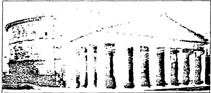
Vista exterior del frente. 32
