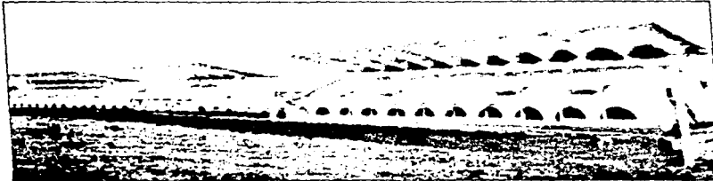
Para las tribunas del Hipódromo de la Zarzuela de Madrid, proyectó en 1935 un sistema de cubierta, con bóvedas en amplio voladizo, agarradas por anclajes situados detrás de los montantes.
