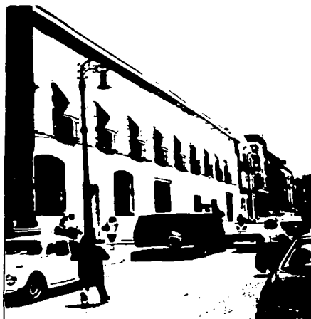
Fotografía de la fachada del ex convento de Santa Inés, después de su última intervención.
