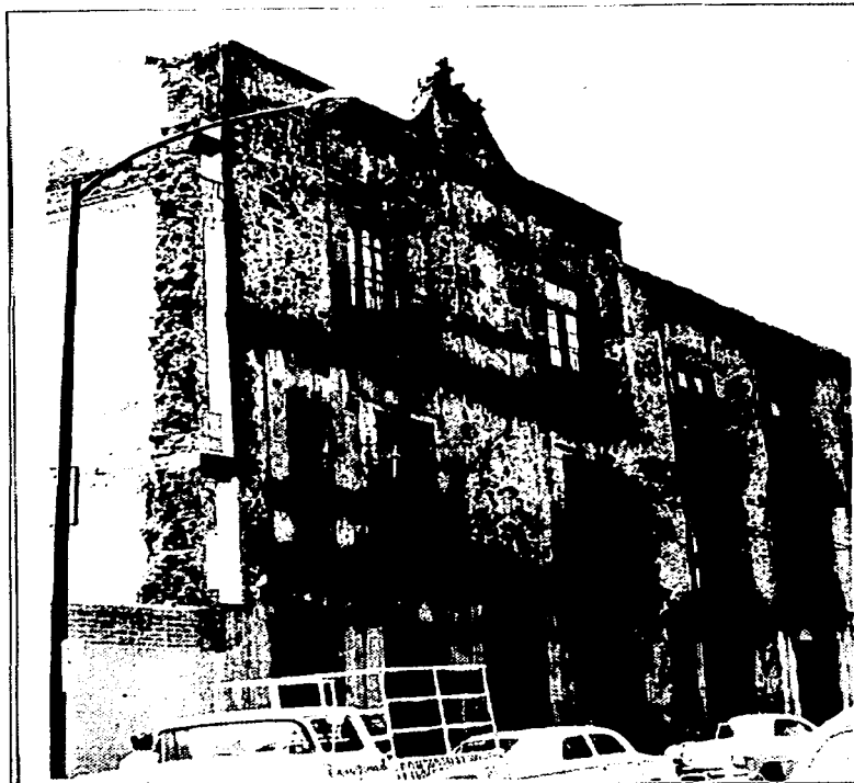
En esta fotografía de 1963, se observa la fachada sin el aplomado, motivo por el cual el Departamento de Monumentos Nacionales demanda que se realice el aplomado de la misma a base de cal y arena. Fototeca de Monumentos Históricos del I.N.A.H. ex convento agustino de Culhuacán.
