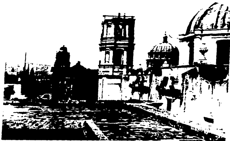
Demolición de la torre de Santa Inés, en marzo de 1861.
