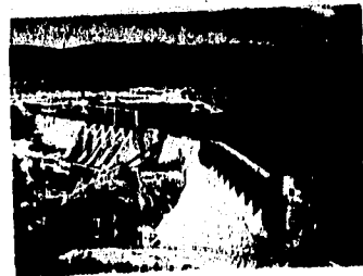
Vistas generales de centrales hidroeléctricas
