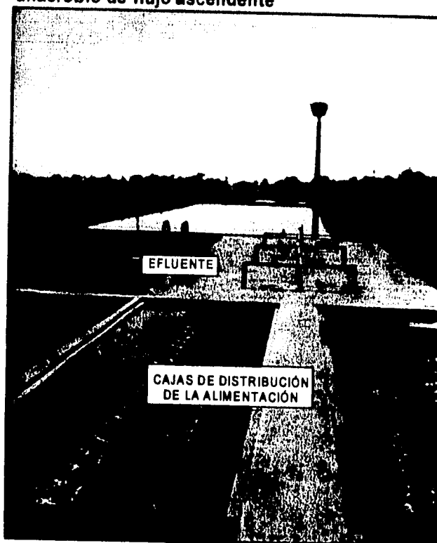
Figura A.3. Vista superior de parte del reactor anaerobio de flujo ascendente
