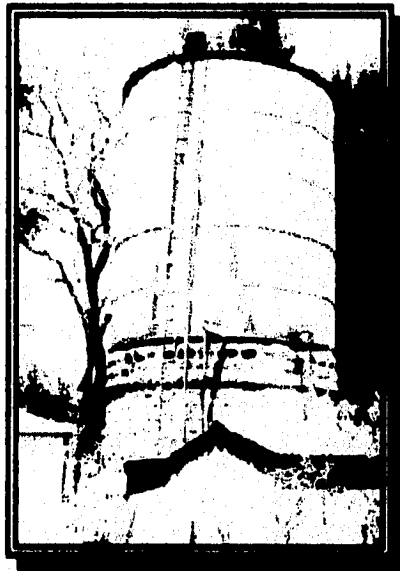
Tanque de agua ubicado en la estación de Querétaro
