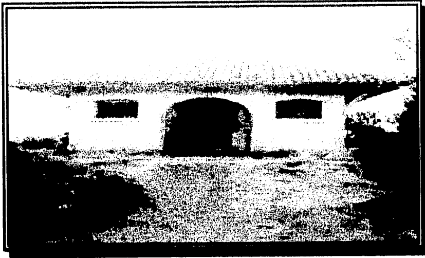
Fachada lateral izquierda de la estación Compostela Antigua PAT1524A
