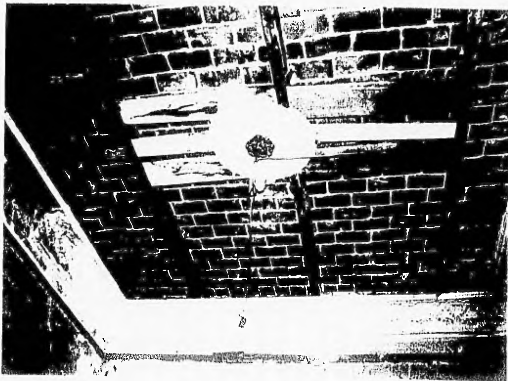
SISTEMA DE AZOTEA CON EL QUE CUENTA ACTUALMENTE EL EDIFICIO (BOVEDA CATALANA).
