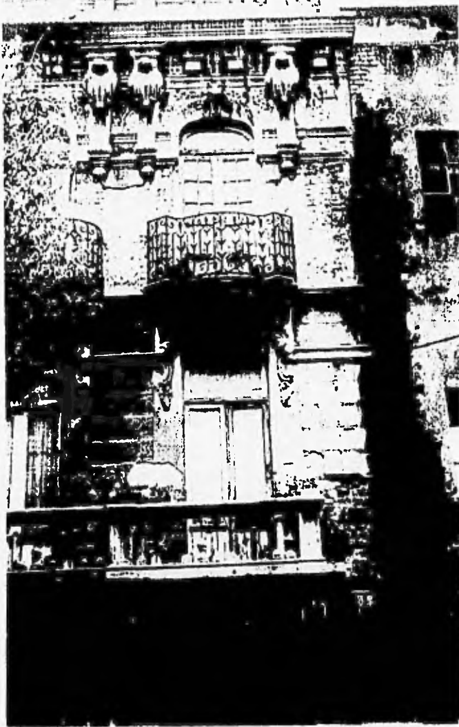
Parte de la fachada donde se muestra la caída del acabado y la falta de algunos elementos de adorno.
