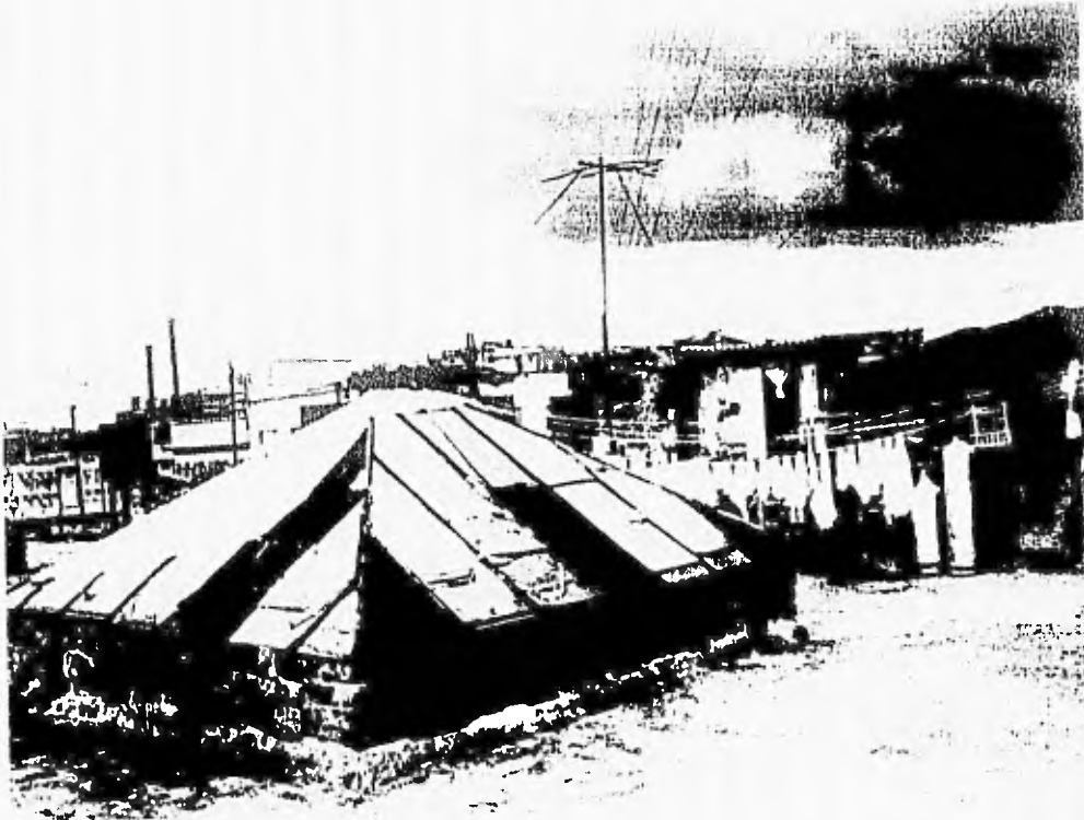
Vista de azotea con viviendas en estado precario.
