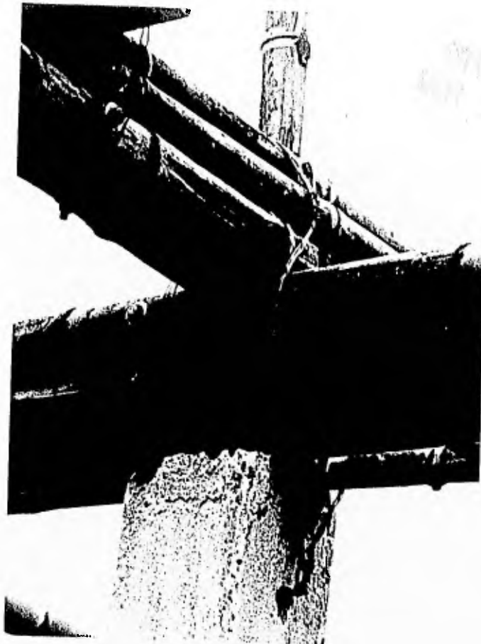
Fig. 16i La viga central de sección compuesta por cuatro otates recibe a la cuerda inferior de la armadura por medio de pernos y ambas se fijan al castillo con un amarre de alambre inoxidable.
