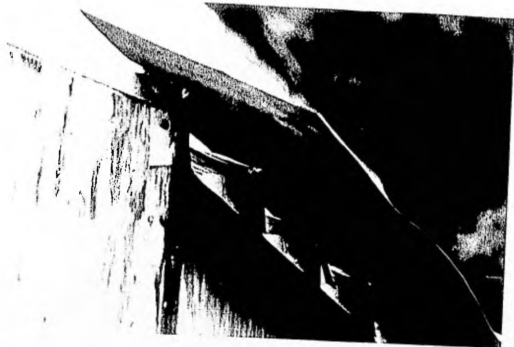
Fig. 17b Extremo inferior del colector, por donde entra el aire del medio ambiente.
