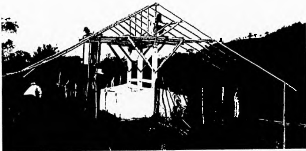
Fig. 16b Colocación de la cuerda superior, diagonales y puntales perimetrales para estabilizar la estructura durante el proceso constructivo.
