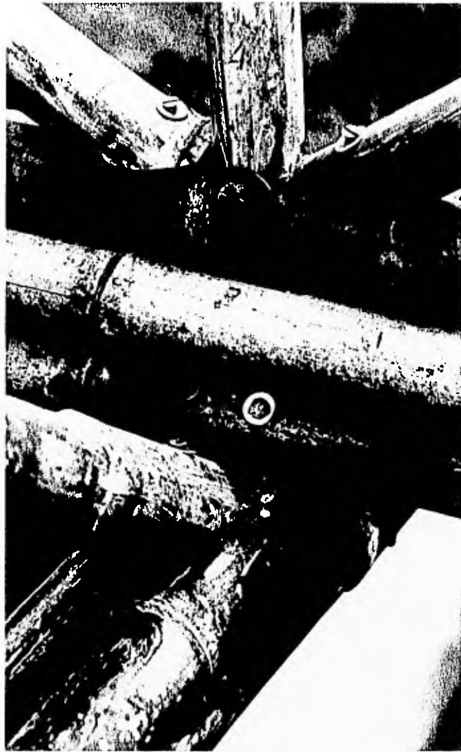
Fig. 16e Viga central de sección compuesta por cuatro otates que recibe a un elemento diagonal colocado en sentido longitudinal y a la cuerda inferior que recibe al montante y a las diagonales de la armadura.
