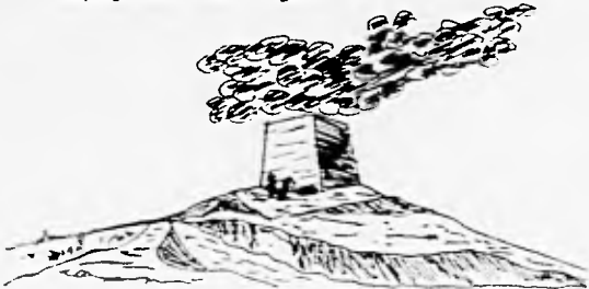
El Acceso al Horno Entre Las Excavaciones.
