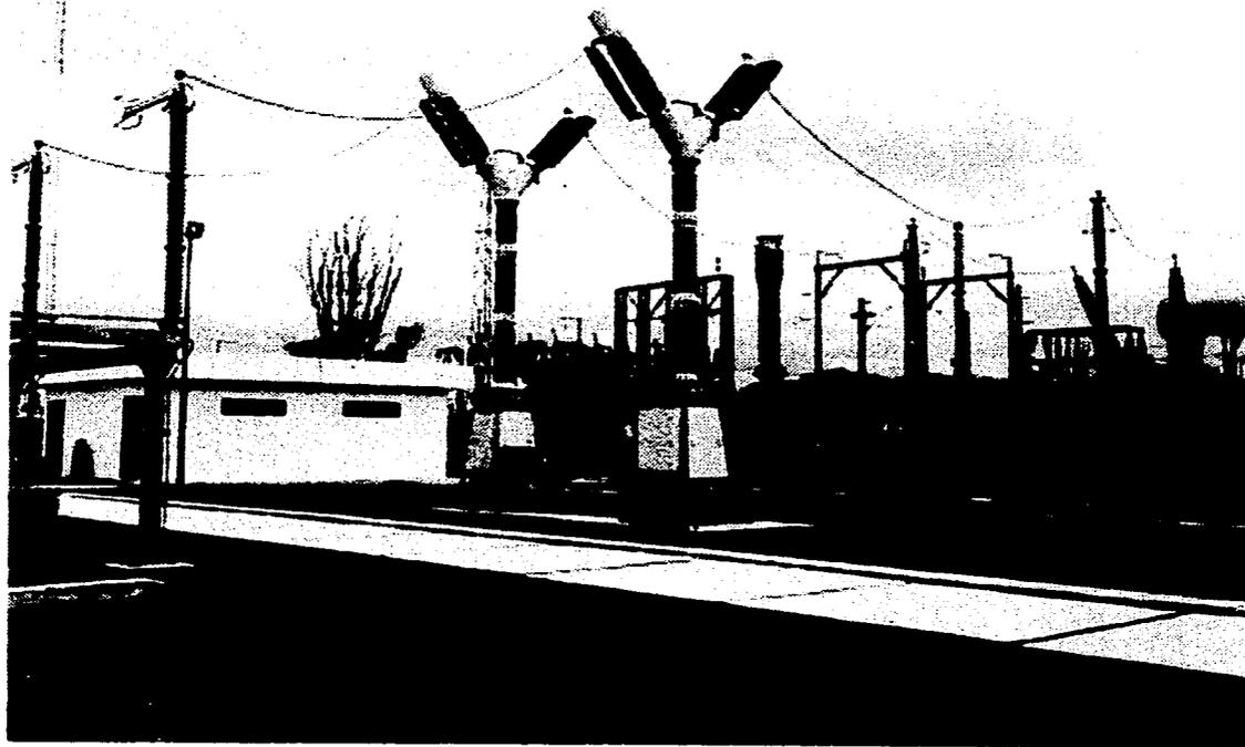
FIG 9 INTERRUPTOR BIPOLAR (IP).
