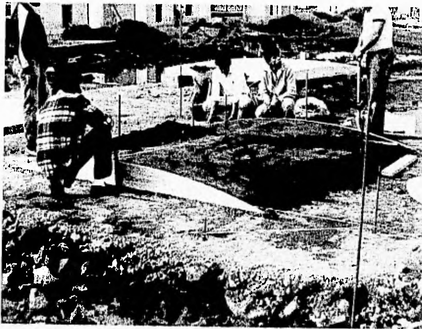
Construcción de molde de 2.70 x 2.70
