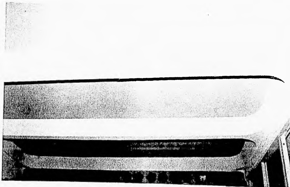
Vista interior de los casetones de 1.20 x 3.00 mts.
