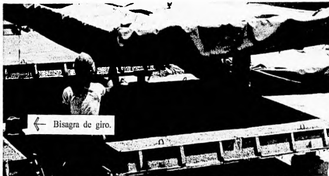
Molde metálico equipado con bisagra para giro de 180°
