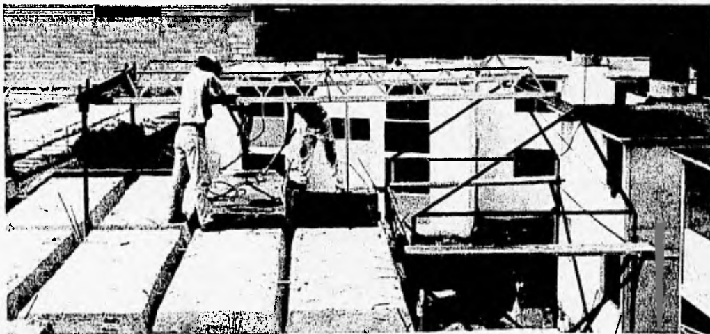
Colocación de losas de 1.30 x 3.00 m con equipo manual
