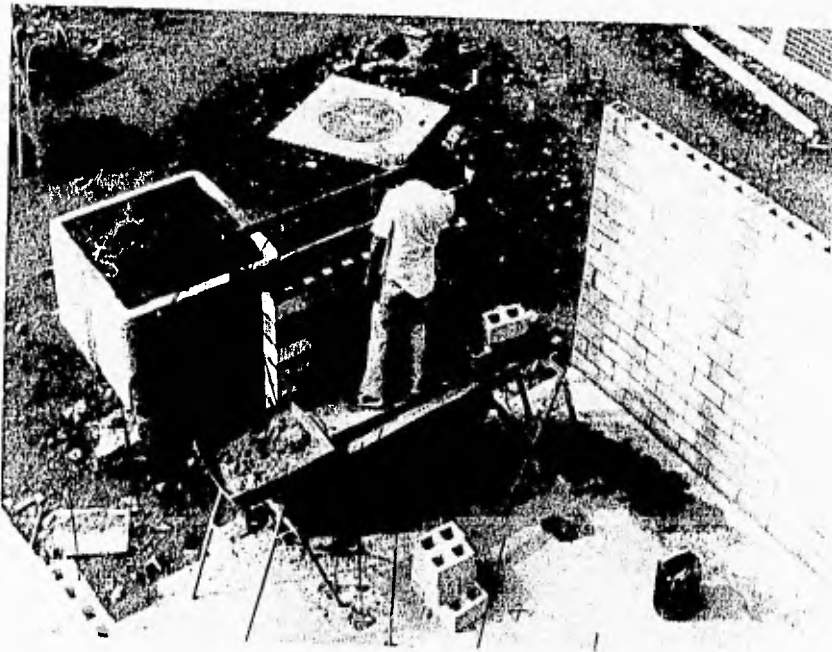
Muro de block sílico calcáreo de 1.20 .
