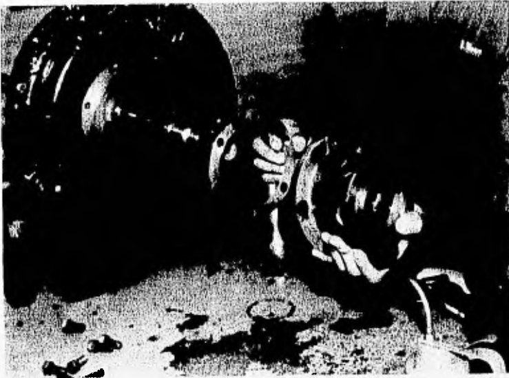
DESMONTAJE DEL CARTER QUE CONTIENE LOS ANILLOS DE CARBON
