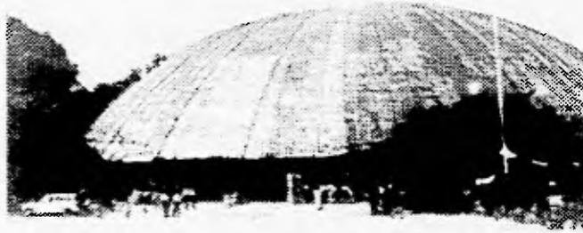
*Tambien mencionaremos el Museo de Historia Natural, el cual fue inaugurado el 15 de Enero de 1981, dicho museo se construyó en concreto con losas prefabricadas, se utilizo tabique aparente de dos celdas. Por ser un terreno de tepetate su cimentación es a base de zapatas aisladas y su planta es rectangular.*
