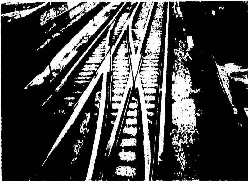
fig.6 Aparatos de vía tag. 0.13 en vía principal
