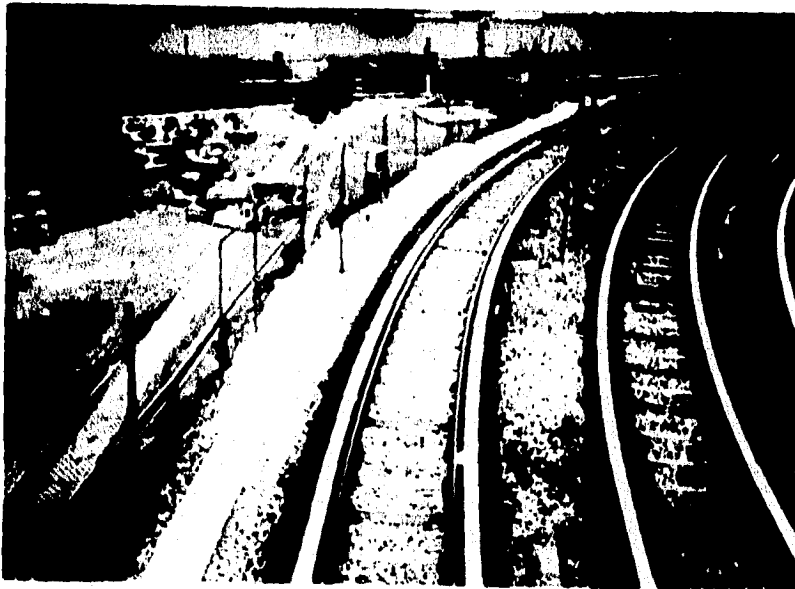
Figura 1 Vía sobre balasto con sus principales elementos.
