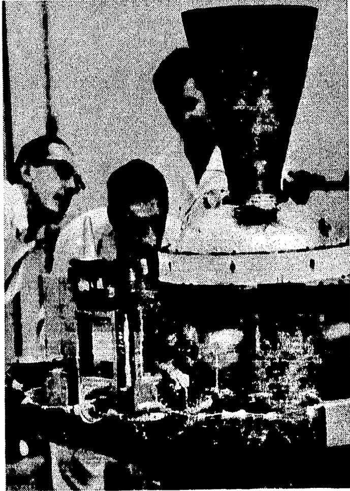
Figura 30. Sistema de propulsión para un satélite de comunicaciones (INTELSAT).
