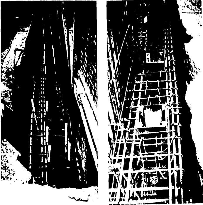
Fotos 7 y 8.- Se aprecia el armado del dado perimetral exterior, así como las preparaciones para poder hincar los pilotes correspondientes.
