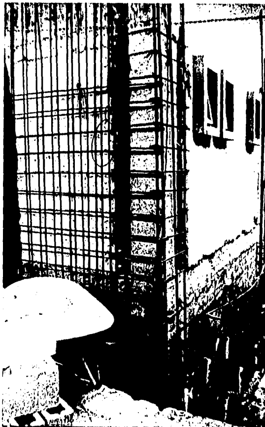
Foto 10.- Modificación de una de las columnas del edificio al tipo " C "
