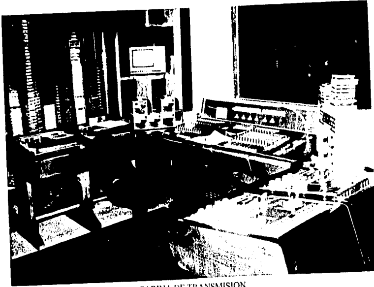
CABINA DE TRANSMISION.
