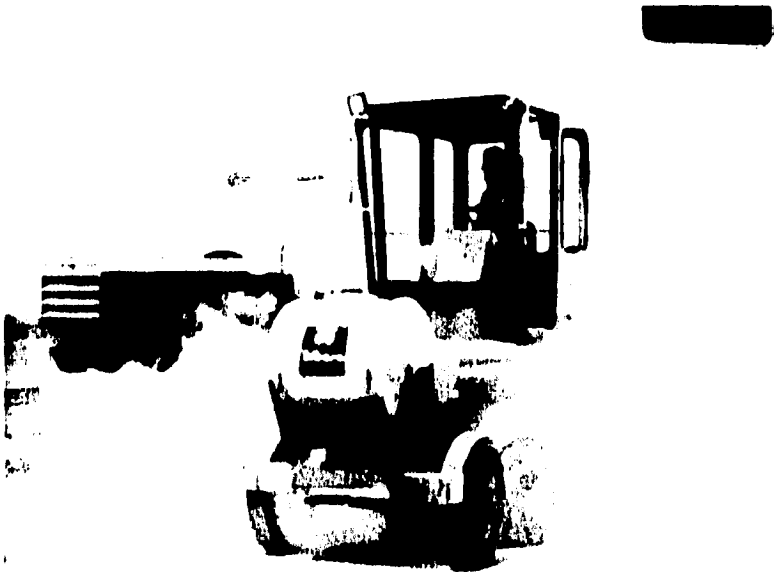
2-11 ANTES DE APLICAR EL RIEGO DE IMPREGNACION, LA BASE ES HARRIDA CON UNA ESCOBA MECANICA, PARA ELIMINAR BASURA, POLVO Y PARTICULAS SUELTAS NO DESEABLES.
