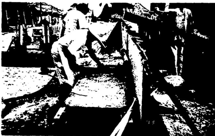
*Antes de que endurezca el pilote se enumeró cada sección para que se tuviera la misma secuencia para el hincado y evitar dificultades en los empalmes de las placas.*
