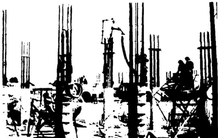
*El vibrado del concreto se llevo a cabo en cada capa logrando el perfecto acomodo de la mezcla y evitando los contenidos de aire, logrando obtener el acabado especificado.*
