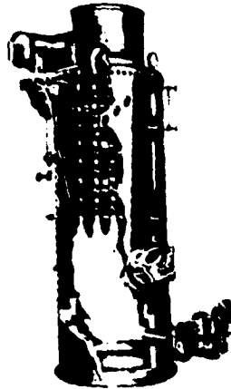
Caldera tubular vertical. Quemador de petróleo, con deflectores espirales de turbulencia de los gases, dentro de los tubos.
