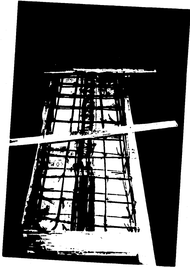
2. Armado de la trabe (Ambos muros).
