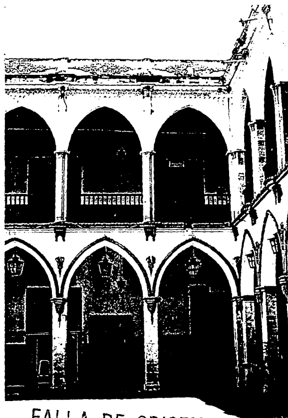
FALLA DE ORIGEN
