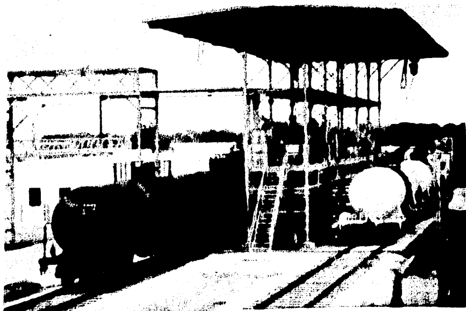
INSTALACIONES PARA LAVADO DE CARROS QUE PRESENTAN DERRAMES DE LOS PRODUCTOS QUE TRANSPORTAN CONSIDERADOS DE ALTO RIESGO
