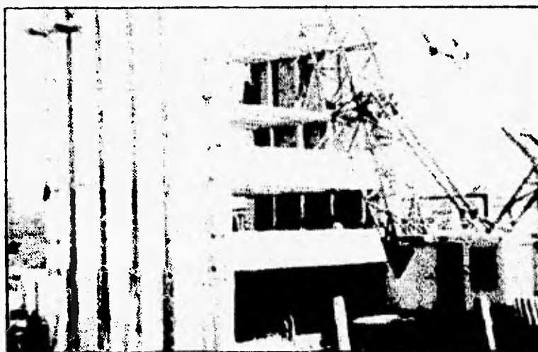
APLICACION DE LOSAS EXTRUIDAS
