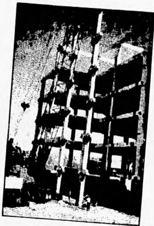
MONTAJE DE COLUMNAS
