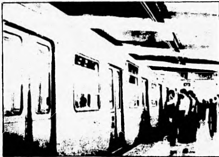
SANTA ANITA, MEXICO, D.F. ACCESOS Y ANDENES DE LAS 10 ESTACIONES DE LA LINEA 4 TECHADOS E IMPERMEABILIZADOS POR SIPOREX de México, S.A.
