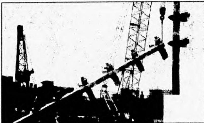
COLOCACION Y PLOMEADO DE COLUMNAS, EDIFICIO PARA OFICINAS DEL COLEGIO DE INGENIEROS CIVILES DE MEXICO.
