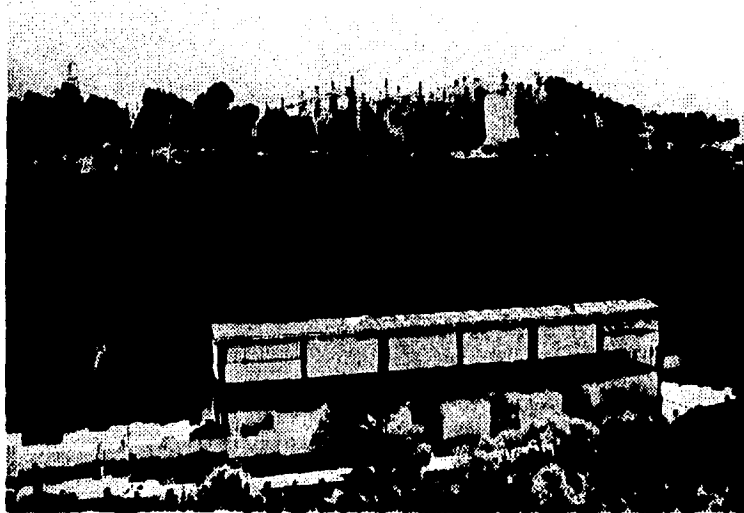
Figura 2.16. Planta de bombeo N° 1.
