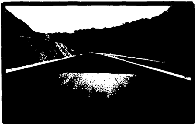
Panoramica en la cual se Observa el Riego de Sello Negro, Cortes, bermas, cunetas y Barra Central de Contención de la Autopista Méx. - Acapulco
