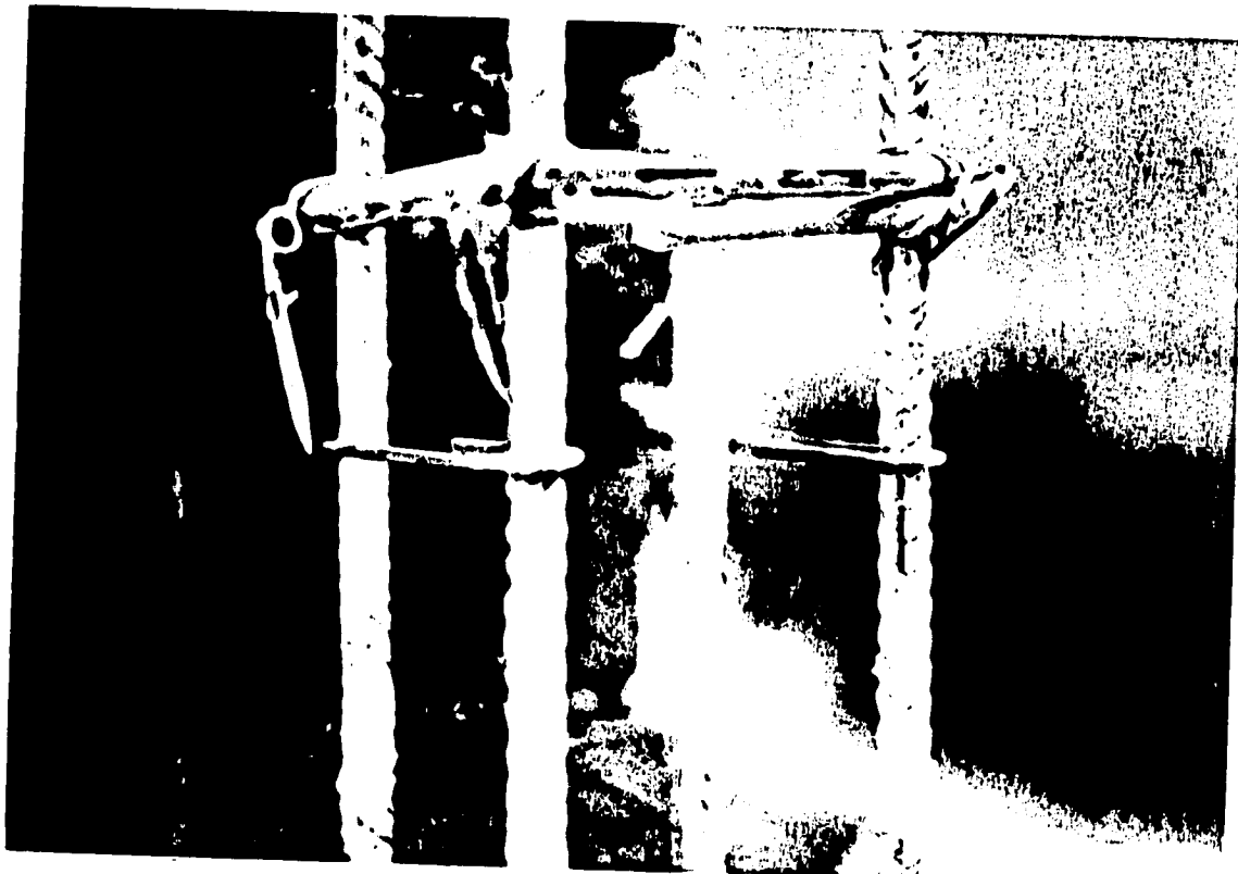
Fig. 1.4.b Anclaje del Refuerzo Horizontal (Modelo WBW-E)
