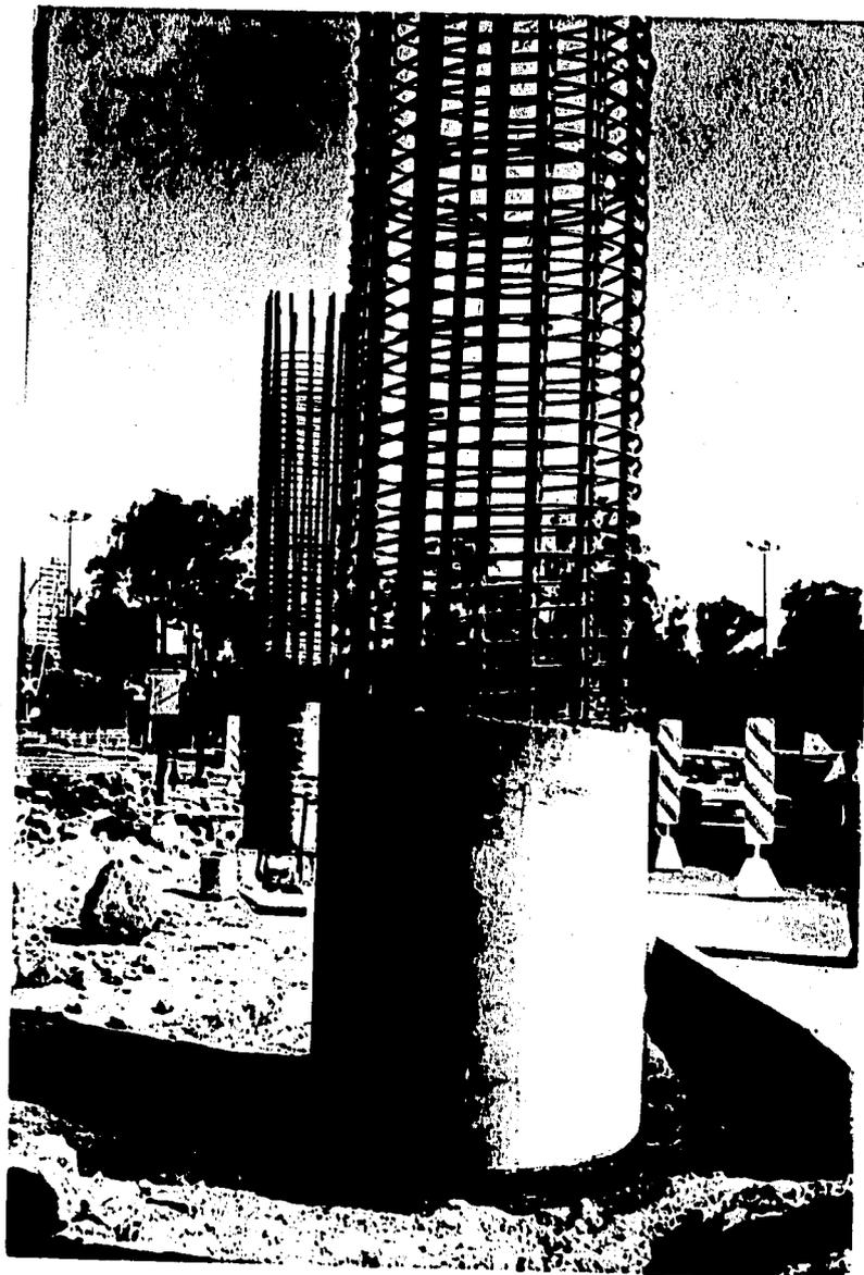
FOTOGRAFÍA 4.8.- COLADO POR SECCIONES
