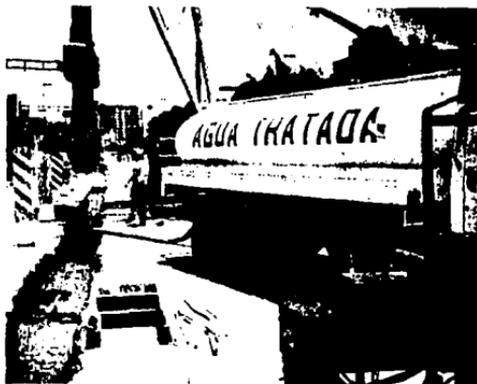
*Fotografía 2.12 Reutilización de grandes volúmenes de agua tratada que junto con la bentonita estabilizan excavaciones y facilitan la construcción. México D.F.*
