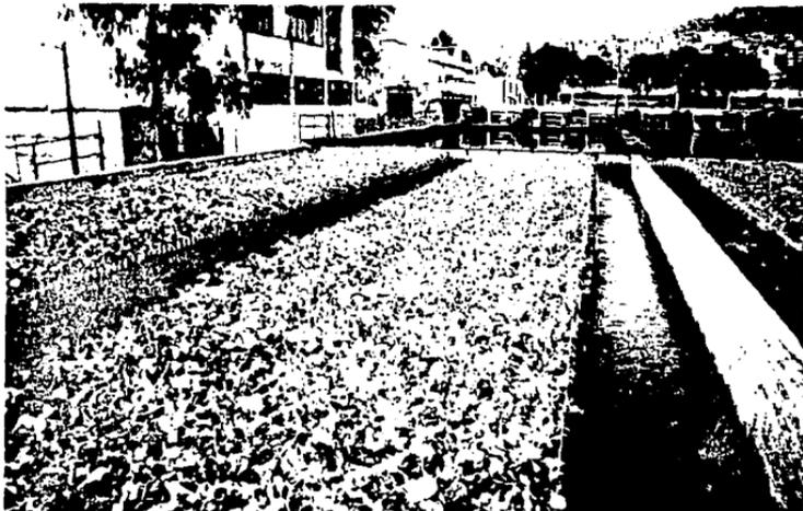
*Fotografía 3.16 Lechos de lirio acuático. tienen como objetivo hacer más eficiente la remoción de contaminantes del agua residual que pasó por el proceso de lodos activados y darle a este efluente una excelente calidad a su llegada por un proceso de tratamiento terciario en este caso la filtración. Planta de Tratamiento Cerro de la Estrella. D.F.*
