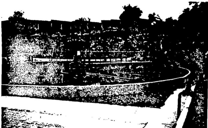
Fotografía 3.7 Tanque circular de sedimentación primaria, Planta de Tratamiento San Luis Tlaxiualtemalco, D.F.
