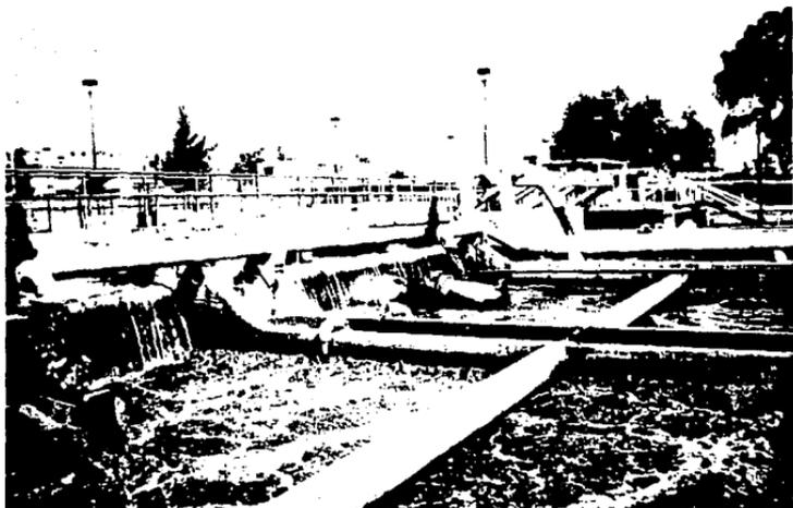
*Fotografía 3.10 Recirculación de lodos a la entrada del tanque, la cantidad apropiada de estos depende la eficiencia del proceso. Planta de Tratamiento Cerro de la Estrella, D.F.*
