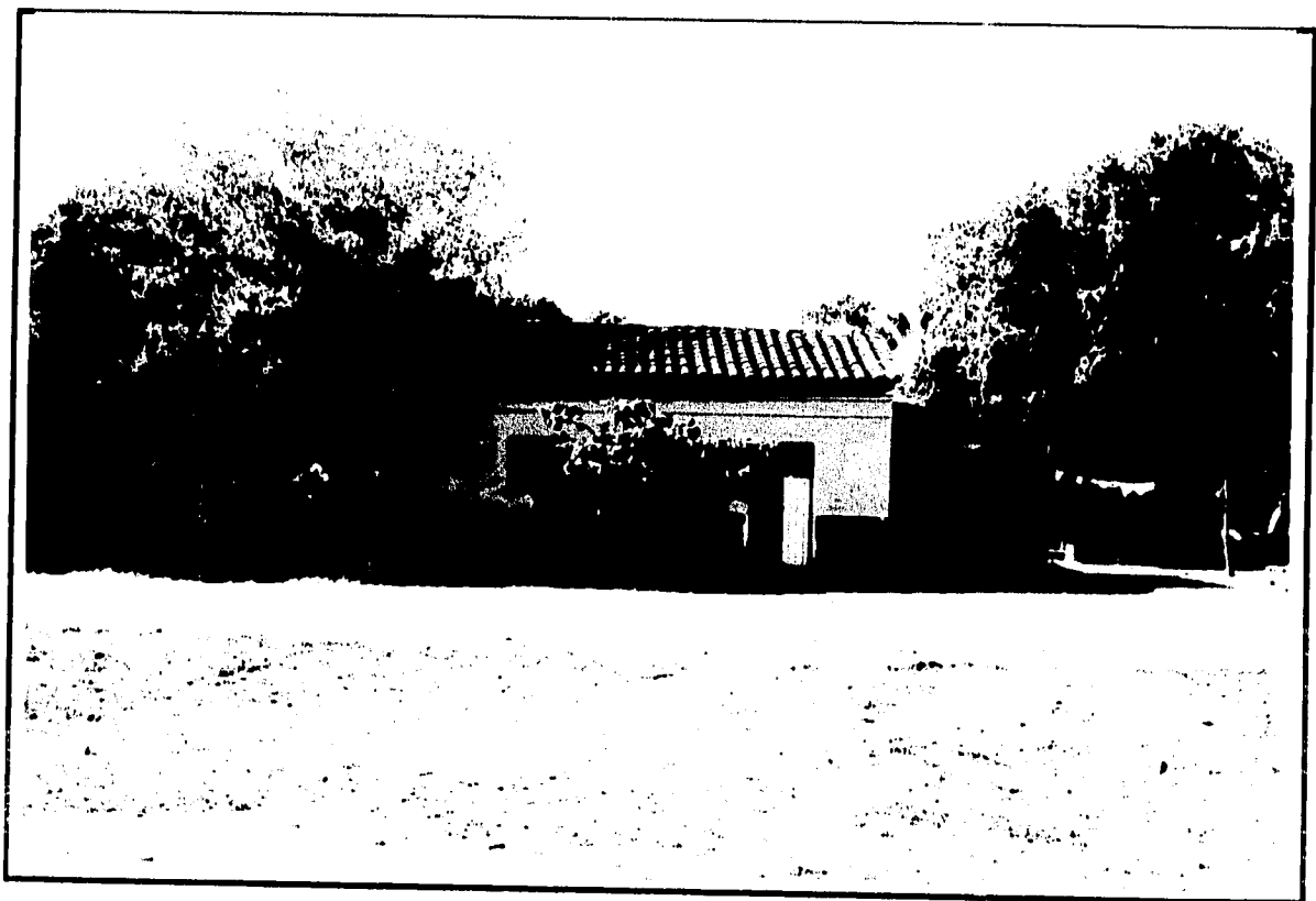
Viviendas de San Francisco del Mar, Oax. (pueblo nuevo)
