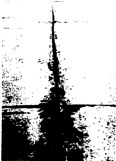
Junta de los sin sellar pista del Aeropuerto de Monterrey, N.L.
