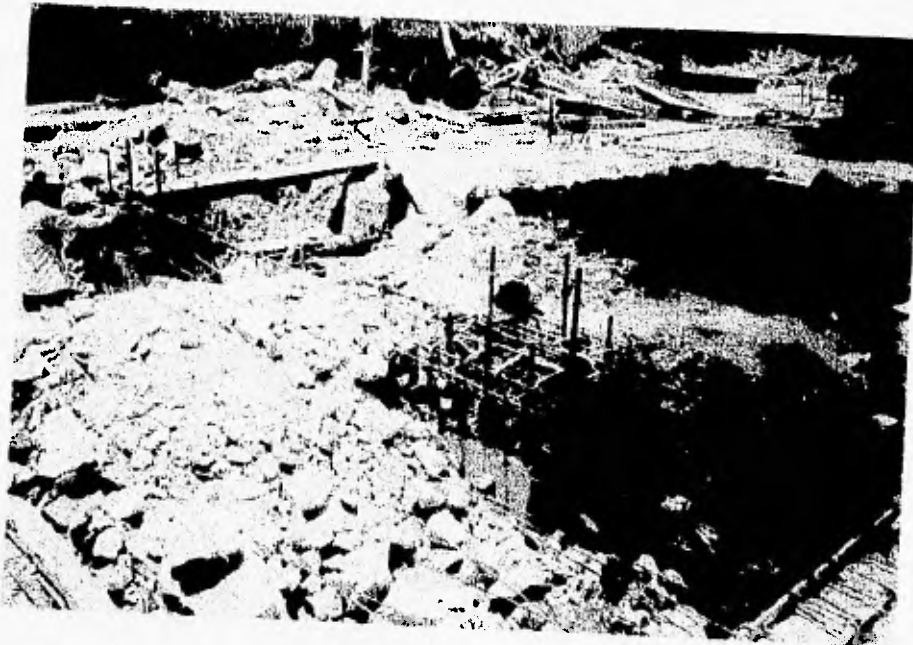
FOTOGRAFIA 3.1 ARMADO DE CAPITEL PARA COLUMNA NUEVA
