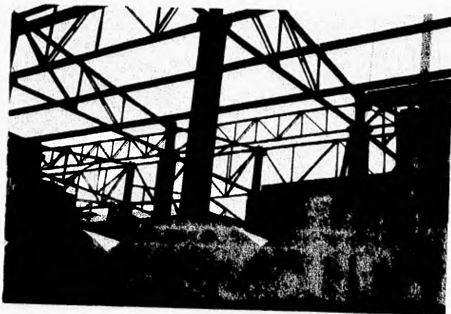
FOTOGRAFIA 4.1 COLOCACIÓN DE ARMADURAS Y MONTENES
