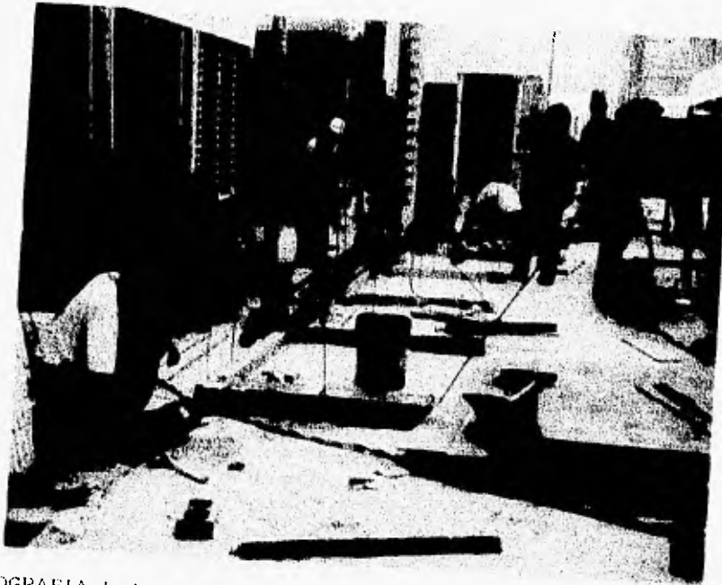
FOTOGRAFIA 5.1 CONSTRUCCIÓN DE LOCAL TIPO
