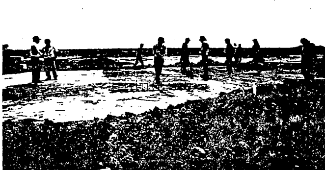
Colocación de la malla electrosoldada
