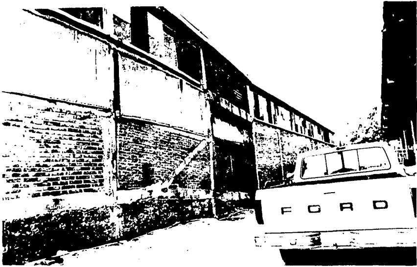
Fig. 35 Daños ocasionados por la falla Oriente en el uso del suelo industrial.
