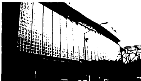
FIG. 6 MURO DE BLOQUES
