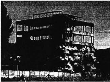
Figura 7. Demolición de una estructura de acero y concreto
