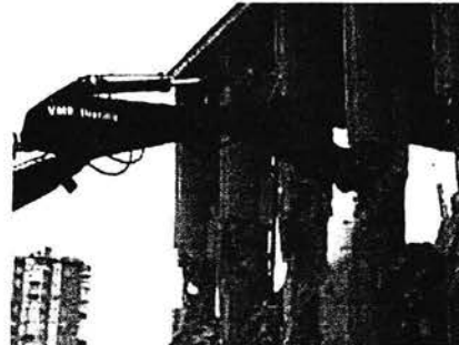
Figura 8. Demolición de columnas de concreto
